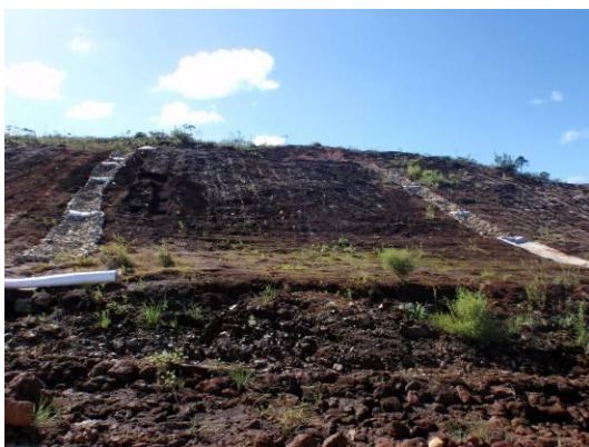
Photo 5 : Drains contre l'érosion
