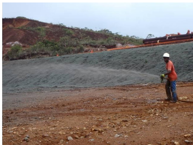
Photo 15 : Hydroseeding sur la verse du ferry par un technicien de SIRAS Pacifique
