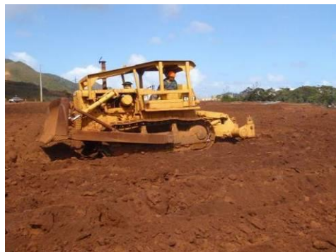
Photo 11 : Décompaction du sol
