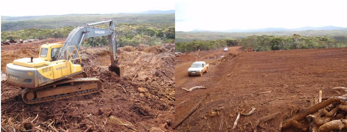
Photos 7 et 8 : Réalisation de la plate-forme
