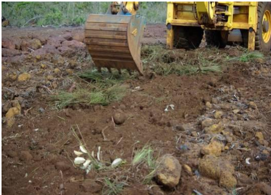
Photos 13 et 14 : Extraction et étalage des bandes de top-soil sur le sol dénudé du tuyau d'eau de Yaté
