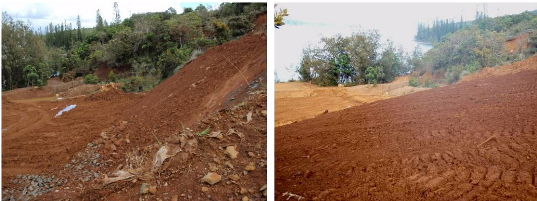
Photos 9 et 10 : Etat de la zone avant et après les travaux.
