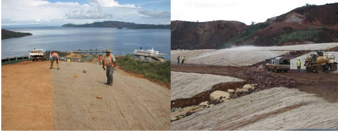
Photos 3 et 4 : Pose de toile de jute sur un talus du convoyeur et hydroseeding sur la verse du ferry
