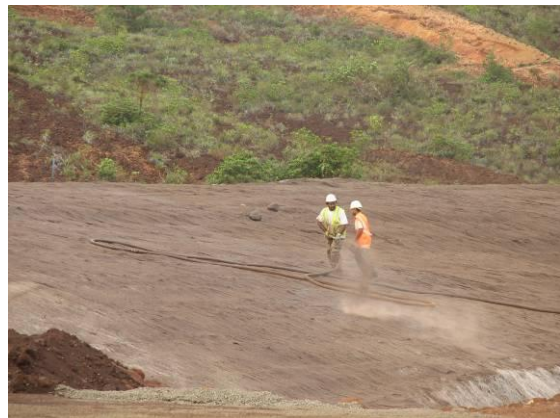
Photo 3 : Ensemencement hydraulique sur la route du port (juin 2007)
