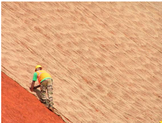
Photo 2 : Pose de toile e jute sur la VSEM (mai 2007)
