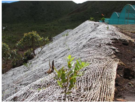
Photo 6 : Talus réhabilité sur le site de la nouvelle pépinière (juin 2007)
