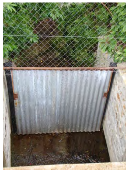
Clôture et plaque en tôle sur le thalweg 2 au droit de l'OH8
