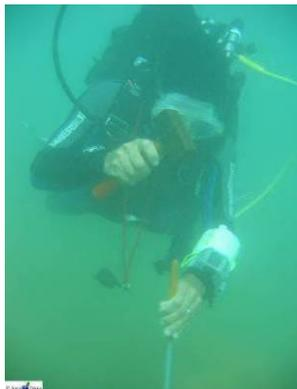
Photo n°1 : Mise en place d'un piquet
