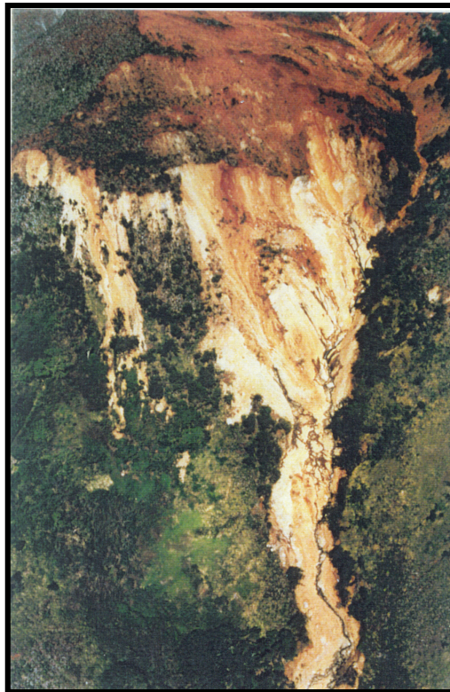
Figure 10 - Photo du front de la coulée au niveau des lotissements Mille et Berton (vue aérienne du Sud).
