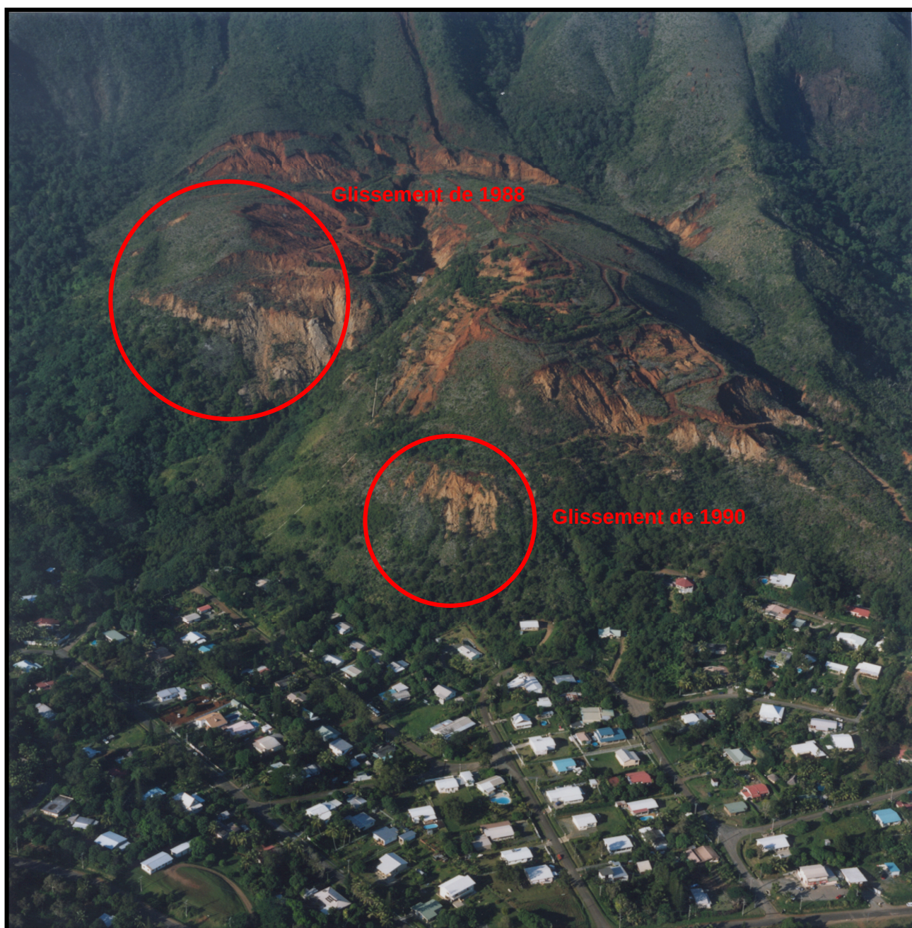
Figure 13 – Vue oblique du dôme du Mont-Dore au-dessus des lotissements Mille et Berton en 2000, vu d'hélicoptère (photographie M. Baillaut, GéoEx)
