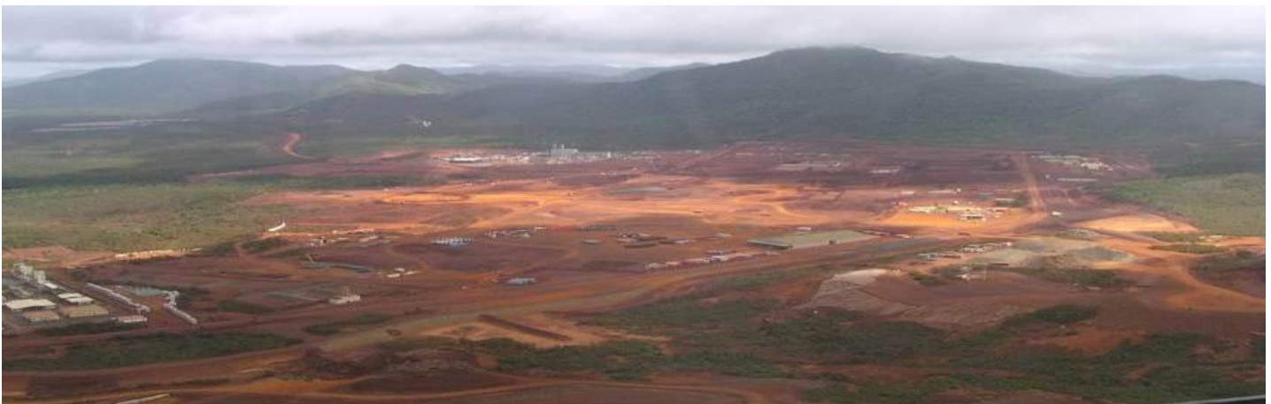
Figure 3 : Etat de la construction de l'usine de Goro-Nickel au mois de novembre 2005.
