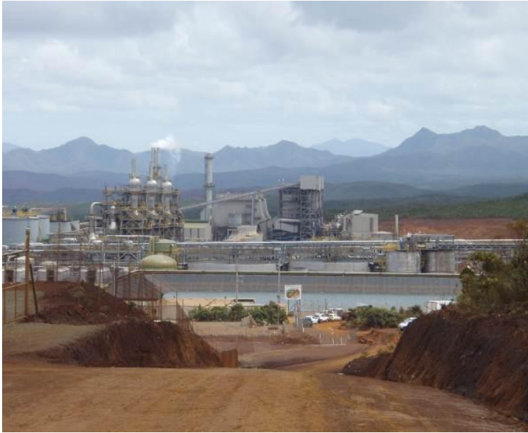
Figure 4 : Usine de Vale-NC: vue des réacteurs d'extraction acide en mars 2009.
