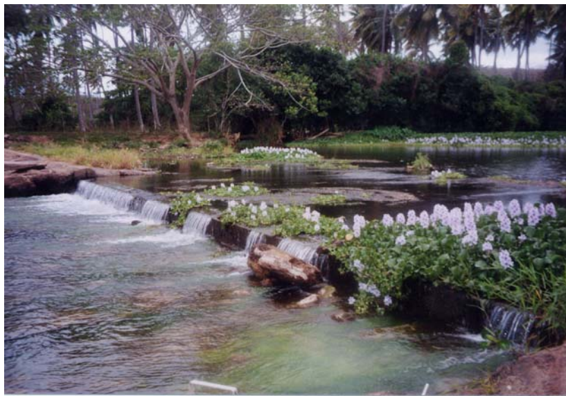
Figure 1.6 : Barrage anti-sel de la rivière Koné avec herbiers d' E. crassipes (photo N. Mary, étiage 2000)
