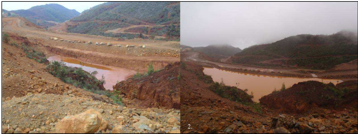
Figure 33 : Décanteur FRN01 ; 1. Décanteur vide ; 2 : Décanteur déversant
