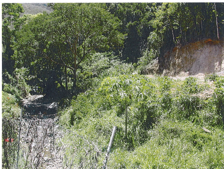
Photographie 8 : Le remblai, certainement destiné à recevoir une construction, est édifié dans le lit majeur du creek (Haut bassin versant de la Namié). Il réduit la section hydraulique et provoque une augmentation des vitesses qui se traduit par une érosion plus active des sols, dont les traces sont déjà visibles immédiatement à l'aval du site.
