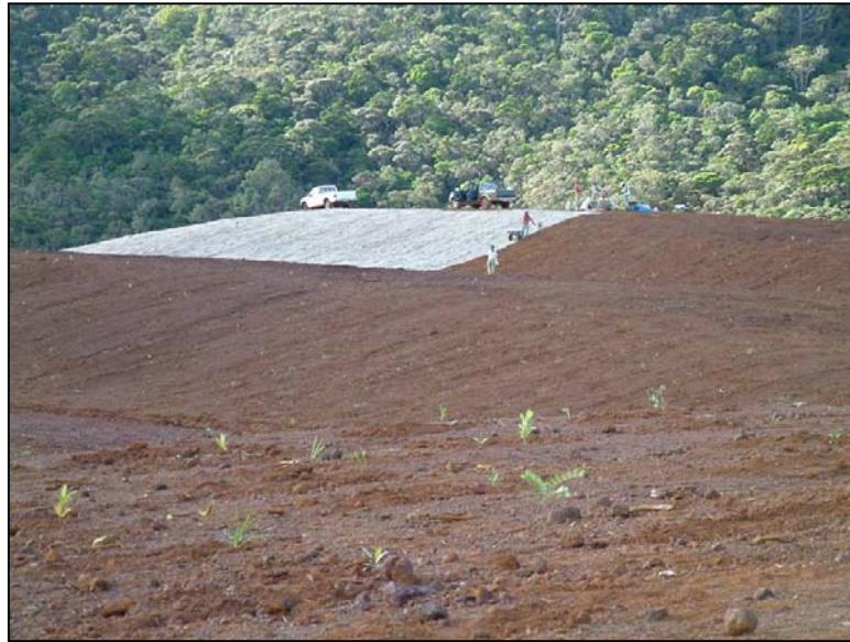
Figure 19 : Préparation du terrain et revégétalisation avec toile de jute
