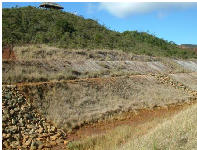
Figure 13 : Revégétalisation par SIRAS du caniveau périphérique de l'usine de Goro avec des graminées exotiques. 5 mois après la strate herbacée morte représente un risque de feu non négligeable.
