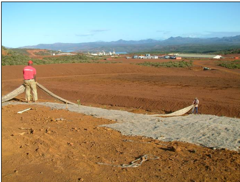
Figure 28 : Mise en place de toiles de jute après plantation et semis
