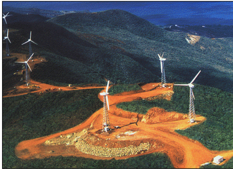
Figure 9 : Vue aérienne des éoliennes du col de Plum
