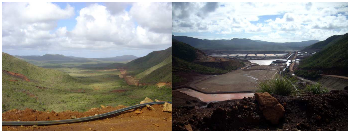
Photo 13 : Fond de la plaine de la Kwé ouest en 2004 à gauche en 2008 à droite. Zone de dépôts des résidus miniers. Une très grande superficie de maquis minier a été décapée entre les forêts de Forêt Nord et Forêt S2. Le corridor écologique est maintenant scindé sur ce tronçon.
