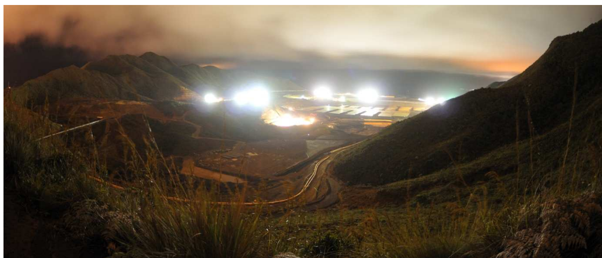
Photo 15 et 16 : visualisation des verrues lumineuses sur le site. Pour la photo 8 les grosses sources de lumière correspondent à des rampes d'appoint halogènes mal orientés. On en dénombre 6 sur la photo. La Forêt S2 est à gauche de la photo sur le flanc de la colline.
