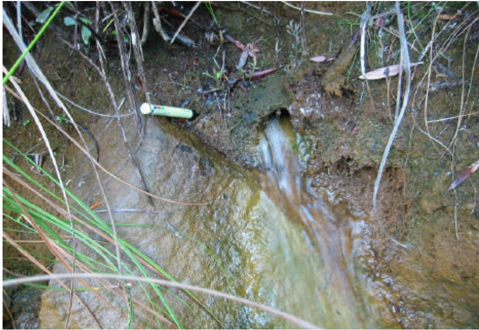
Photo 25: Résurgence d'eau souterraine à travers la limonite en amont de la station TT-SW9 (fév. 2002)
