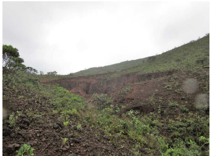
Photo au sol zone CPKE C
