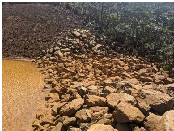
Déversoir du BS4
