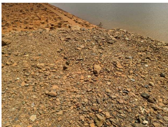
Déversoir du BS6
