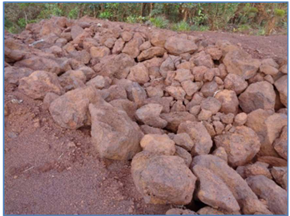
Déversoir du VSEM BS1
