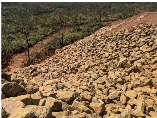
Déversoir du BS11
