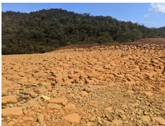
Déversoir du BS5
