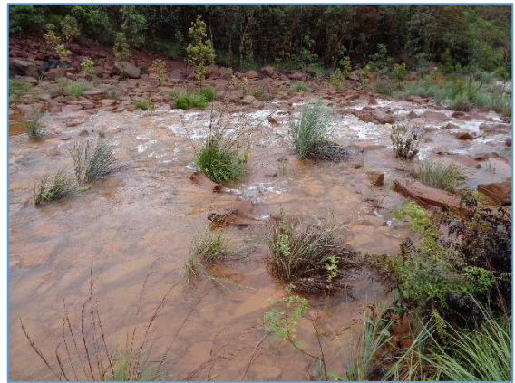
Déversoir du BSO
