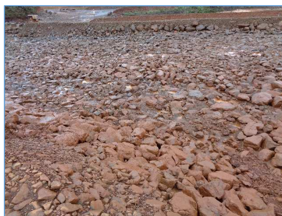
Déversoir du BSC
