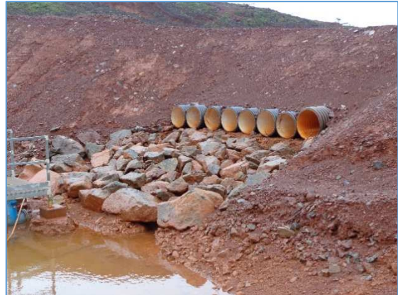
Déversoir du BS7
