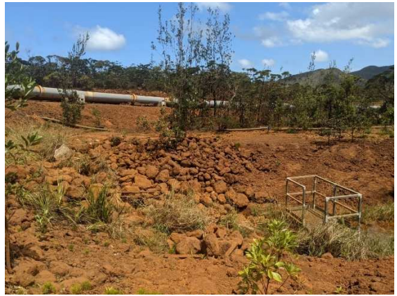
Déversoir du BS1
