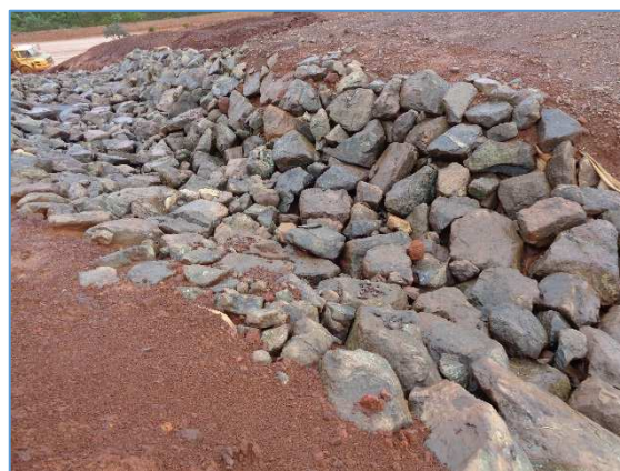
Déversoir du BS16
