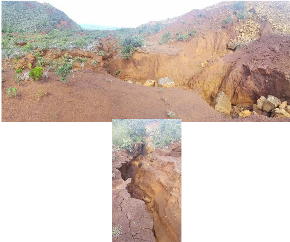
Figure 11 : Érosion des chenaux hydrographiques sur le piedmont en aval de l'emprise de la mine A1
