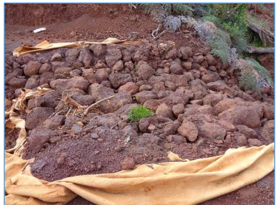
Déversoir du VSEM BS2
