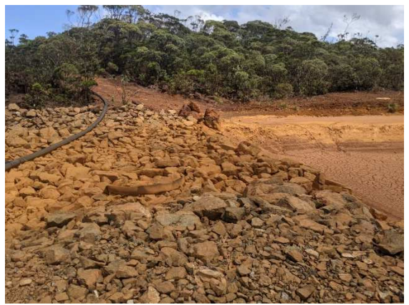
Déversoir du BS3
