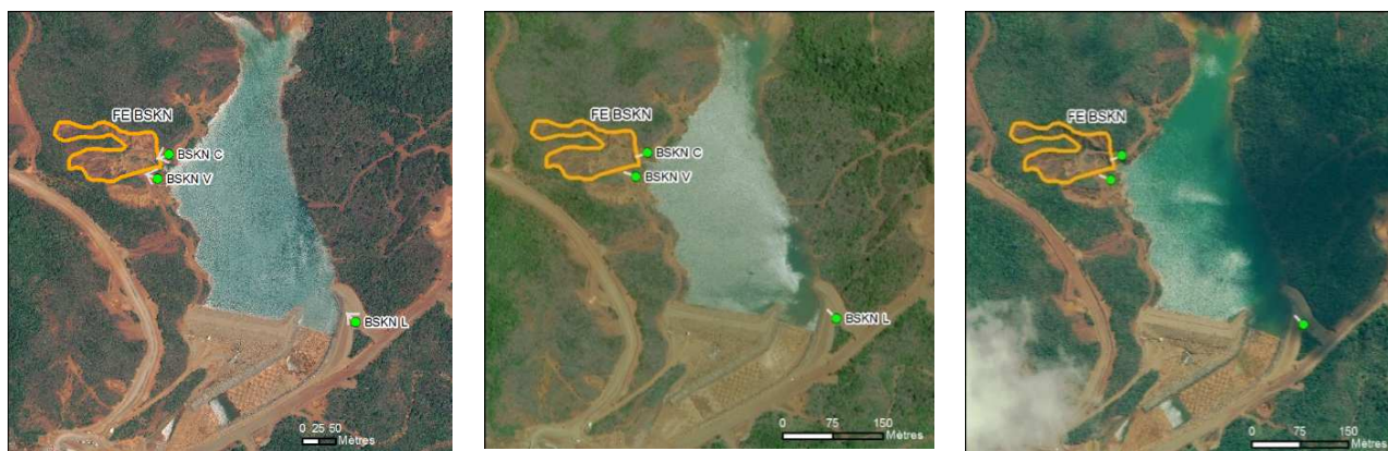
Figure 49 : Photos satellites datant de 2018 (Gauche), 2019 (centre) et 2020 (Droite) centrées sur le BSKN
