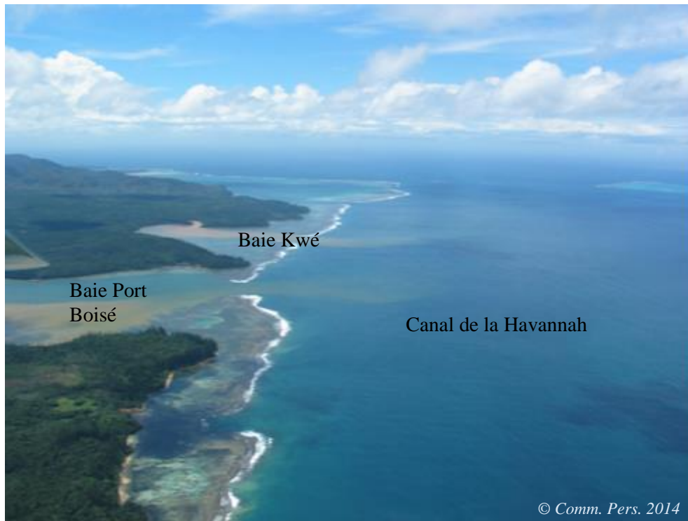
Photographie 01 : Vue aérienne de la zone, après un épisode pluvieux
