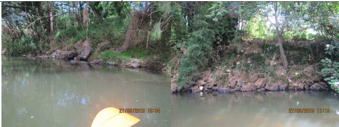
Enrochements de protections en pied de berge
