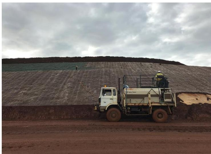
Figure 3 : Exemple de chantier d'hydro-seeding sur la SMLT, 2018
