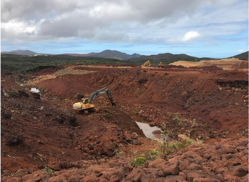
Construction des bassins au sud de la berme
