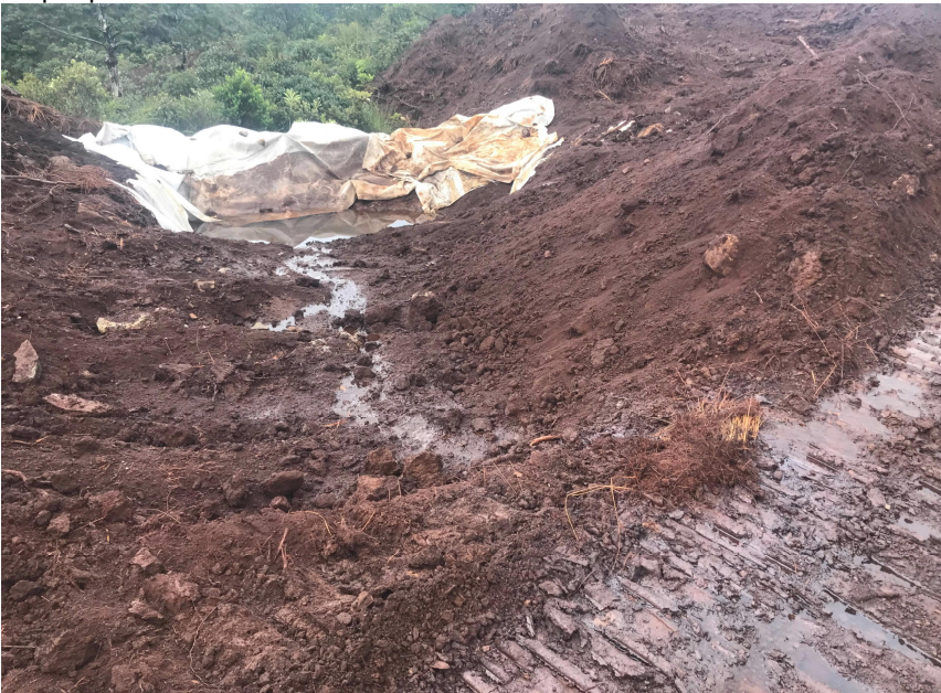
Bassin de décantation de chantier
