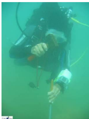
Mise en place d'un piquet
