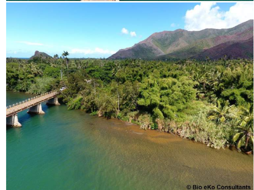
Vue drone depuis la rive gauche vers la rive droite
