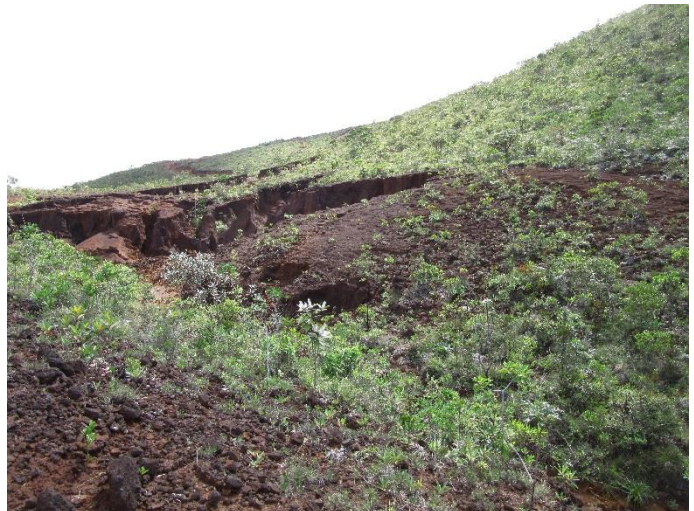
Photo au sol zone CPKE C
