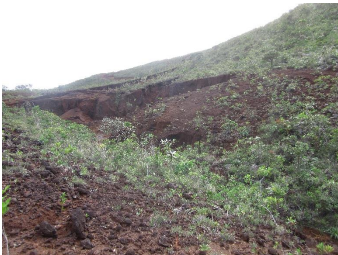
Photo au sol zone CPKE C
