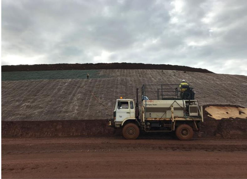
Photo 9 : Réalisation de semi hydraulique sur les talus de la verse SMLT, mai 2018.
