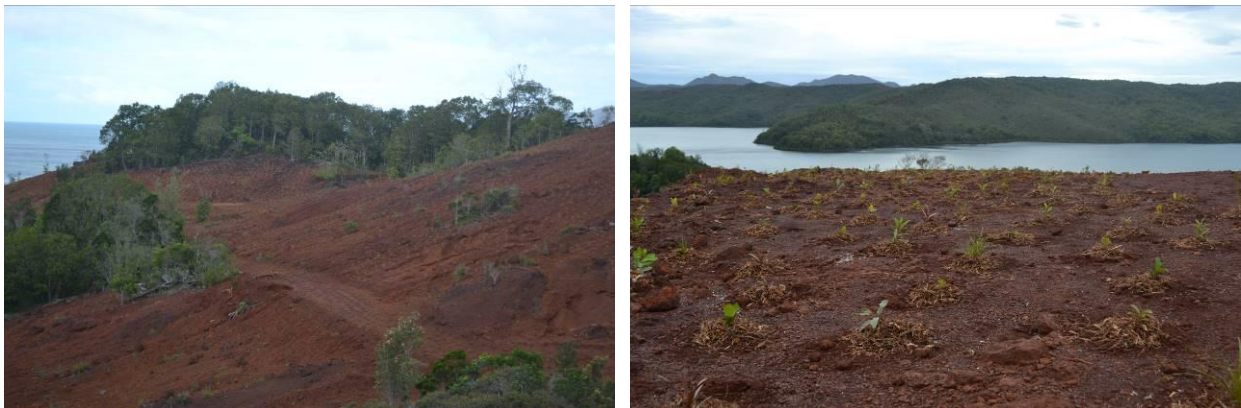
Photo 1 et 2 : Travaux de plantation sur « SOCAMIFER », juin 2018.
