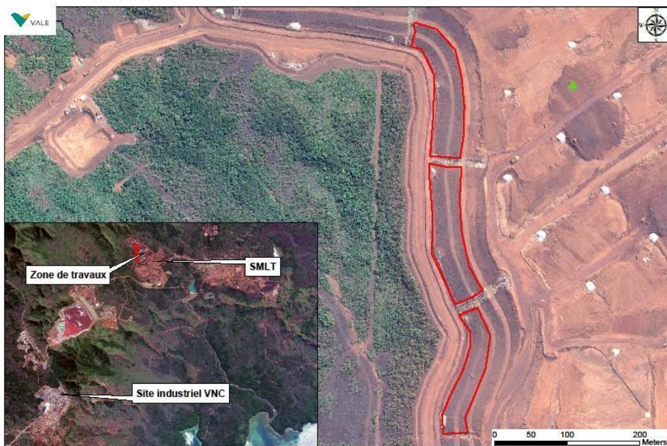
Travaux d'hydroseeding sur les talus du SMLT, Yaté
