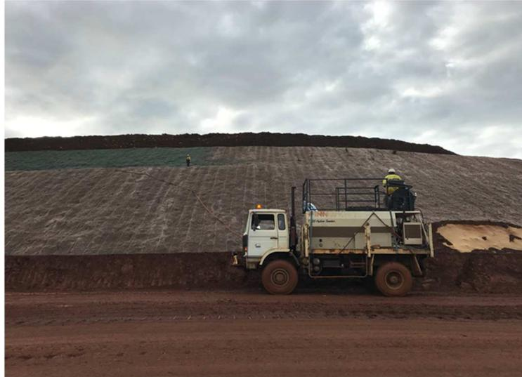
Figure 13 : Exemple de chantier d'hydro-seeding sur la SMLT, 2018
