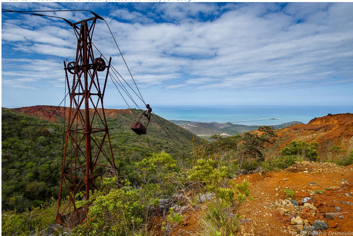
Photo 16 : Ancienne installations minières de Tiébaghi.
