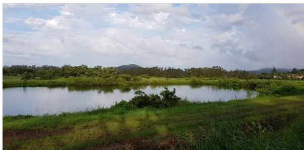
Photo : Premier bassin du lagunage dans le village de la commune de La Foa (Nouvelle-Calédonie)
