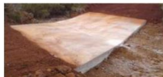
Photo n°3 : Passage à gué bétonné (béton armé) sur cours d'eau temporaire (Périmètre de Madeleine Rive Droite)
