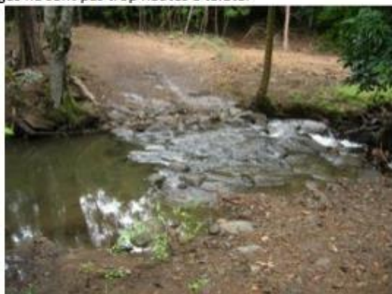
Photo n°1 : Passage à gué empierré sur cours d'eau permanent (Réserve de faune et de Flore de la Nodéla)
