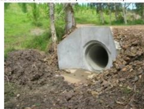
Photo n°4 : Passage busé (buse en béton) de traversé de cours d'eau temporaire avec tête de buse en béton armé avec ailes (Périmètre de Foni boy)
