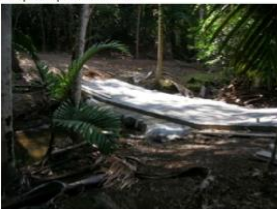
Photo n°2 : Passage à gué bétonné sur cours d'eau permanent (Réserve de faune et de Flore de la Nodéla)
