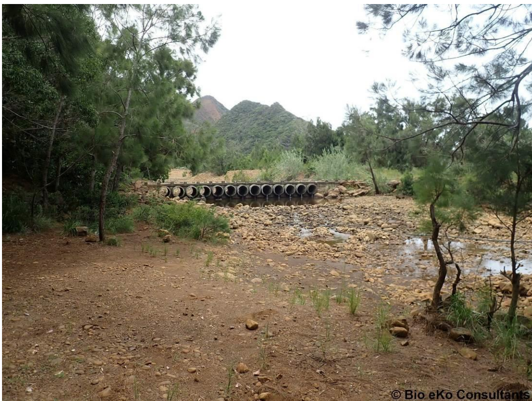
Vue depuis l'aval de la Xwê Ré Mè au niveau de la plateforme du poteau 32
