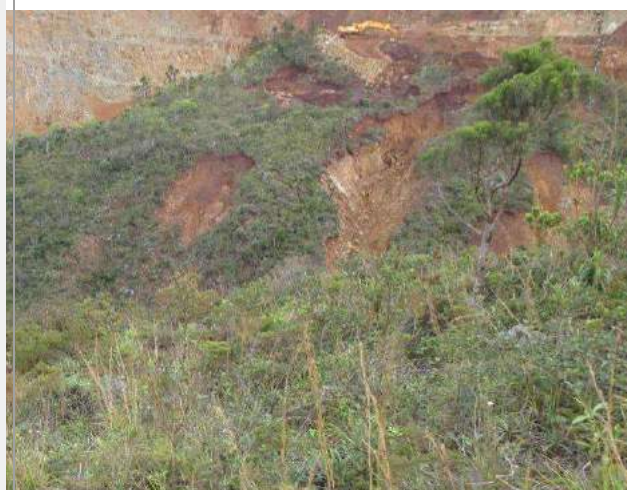
Exutoire sous AC1 (octobre 2009)
