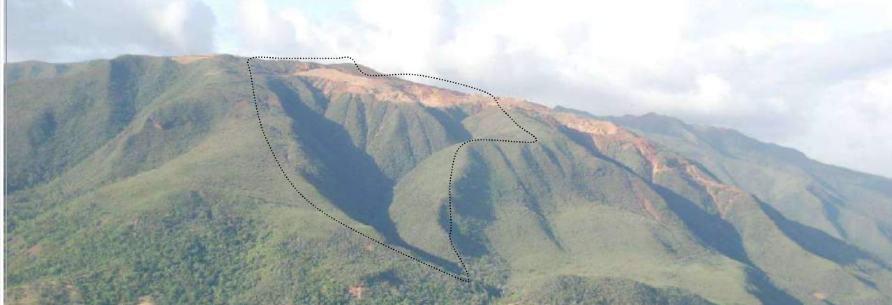
Vue sur la partie haute du BV, talweg ouest
