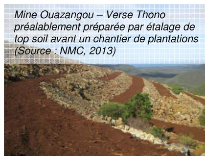
Mine Ouazangou – Verse Thono préalablement préparée par étalage de top soil avant un chantier de plantations (Source : NMC, 2013)
