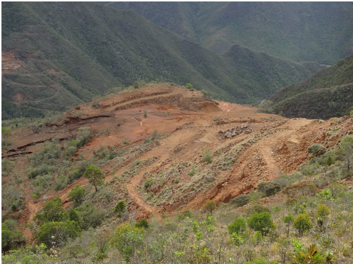
Vue sur l'ancienne carrière de SGM9 depuis le haut de la piste d'accès (Ecosysmine, novembre 2017)
