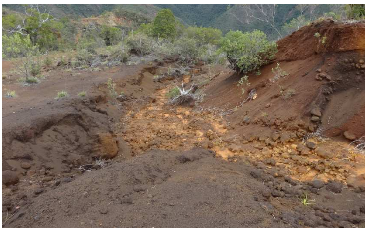
Photo 16: ravinement du chemin hydraulique avant exutoire du bassin versant C (Ecosysmine, novembre 2017)
