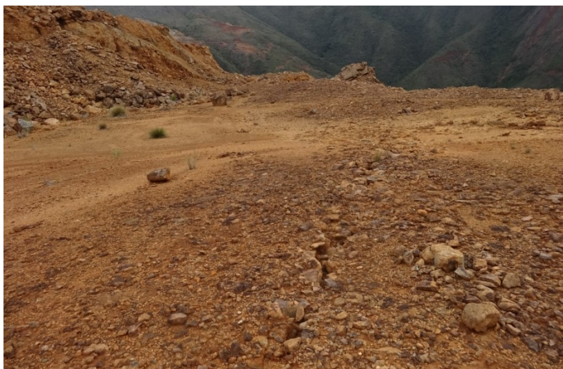
Photo 4 : fissure se prolongeant sur une banquette au Sud de la carrière (Ecosysmine, novembre 2017)
