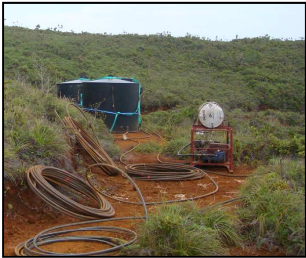
Photo 5 : Matériel d’alimentation en eau du chantier
