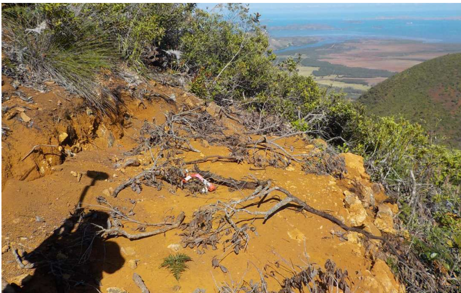
Photo 7 : étales des végétaux coupés sur la plateforme.
