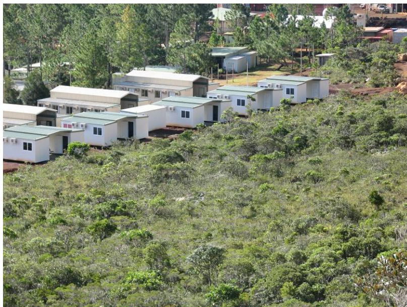
Photo 6 : Localisation géographique de l'extension du camp de la géologie.
