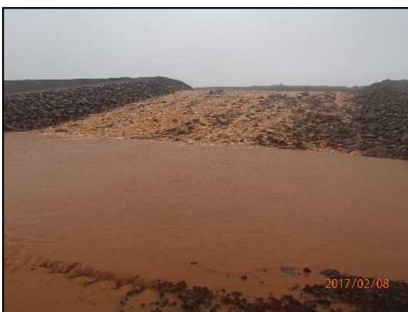
Figure 45 : Vue d'un des coursiers du BS6 lors de l'évacuation du pic de crue, 08/02/17
