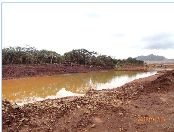
Figure 78 : Vue du bassin BS1 agrandi – 13/04/2017
