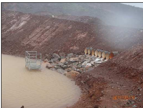
Figure 46 : déversoir du bassin BS7, 08/02/17
