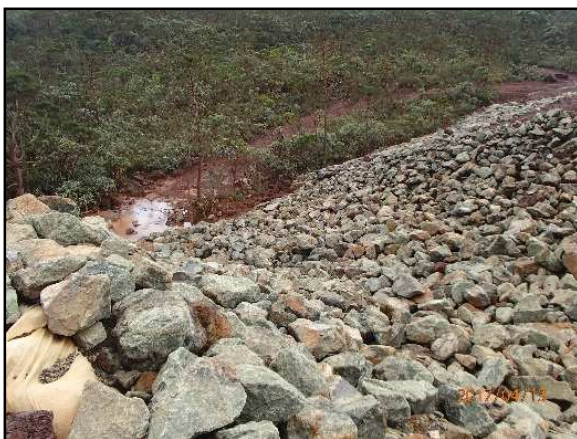
Figure 86 : déversoir du BS11 – 13/04/2017
