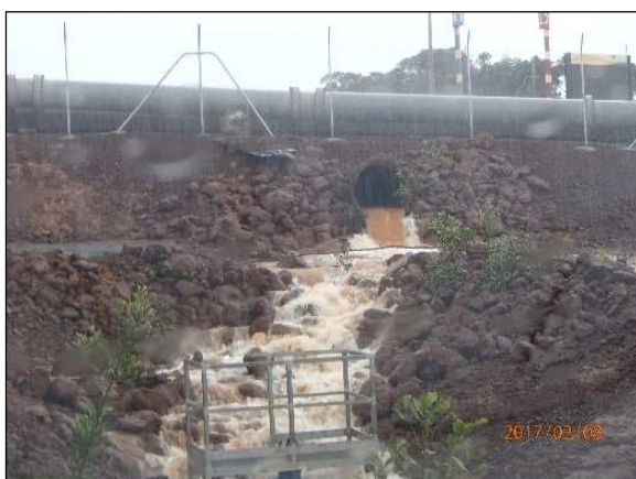
Figure 40 : Déversoir du bassin BS1, 08/02/17
