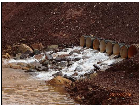
Figure 64 : Déversoir du BS7 – 16/02/17
