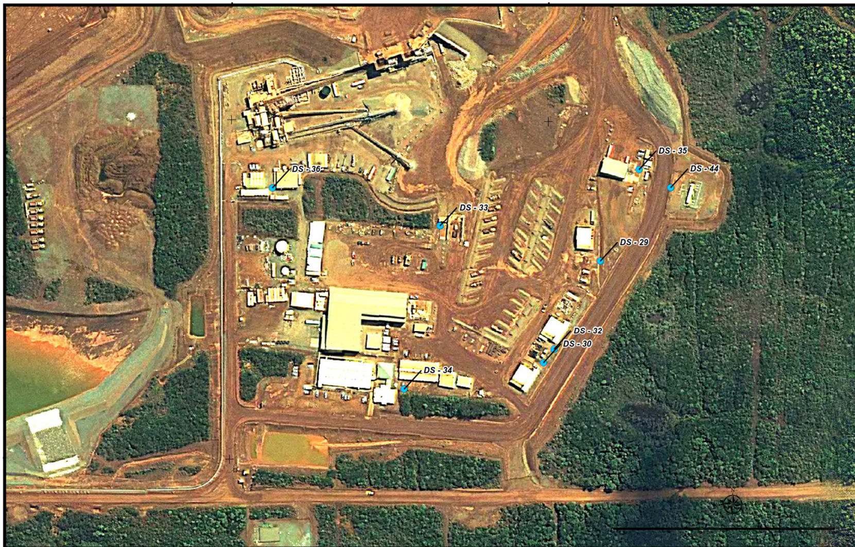
Figure 152 : Localisation des débourbeurs séparateurs de la zone UPM – CIM
