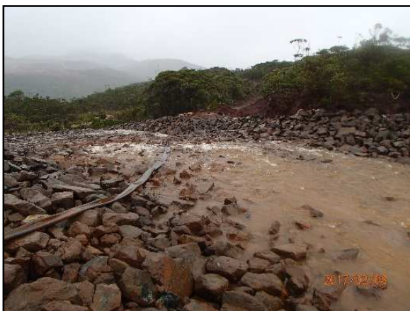
Figure 42 : Déversoir du bassin BS3, 08/02/17
