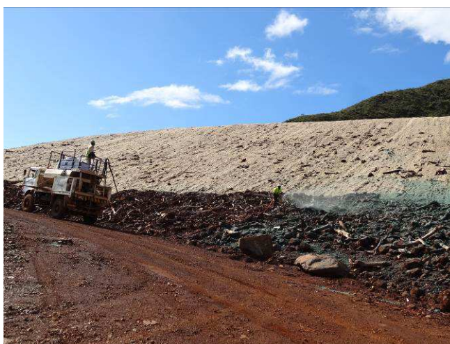
Figure 15 : Exemple de chantier d'hydro-seeding sur la VSKE, 2016
