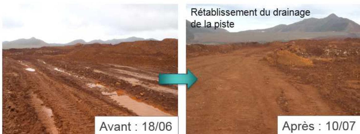
Figure 14 : Rétablissement du drainage de la piste sur SM1
