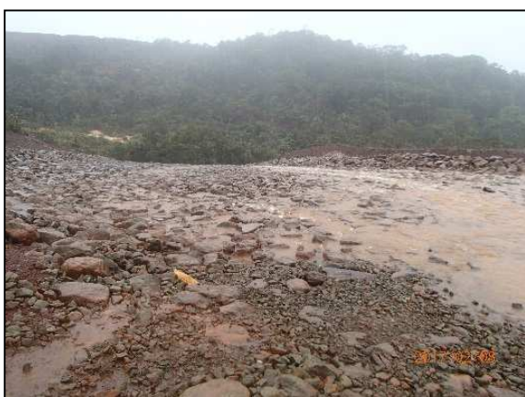
Figure 44 : coursier et déversoir du bassin BS5, 08/02/17
