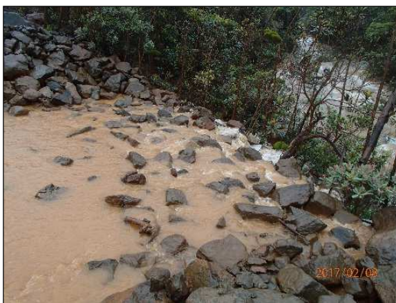
Figure 43 : Déversoir du bassin BS4, 08/02/17
