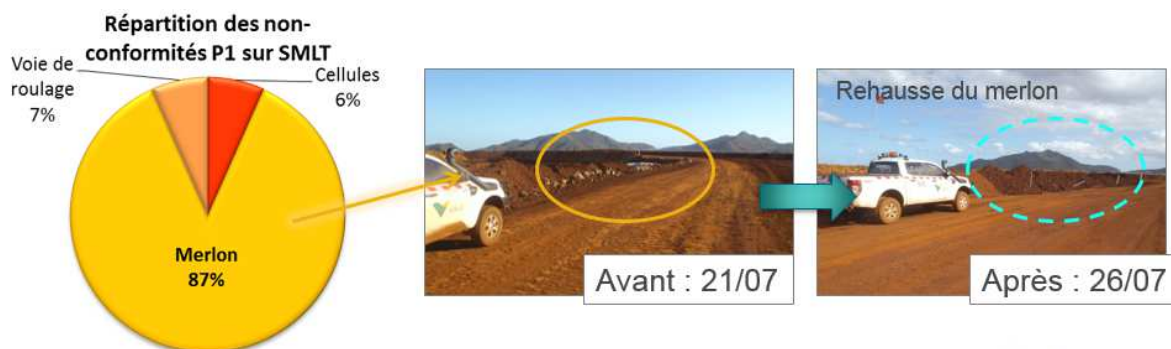
Figure 8 : Statistiques des non-conformités de priorité 1 : exemple de merlon sur SMLT
