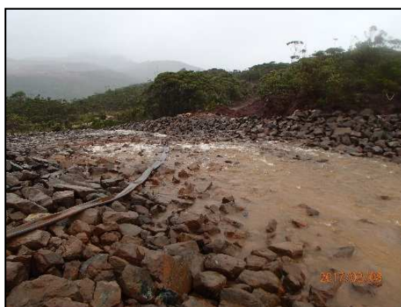
Figure 60 : Déversoir du BS3 – 18/02/17
