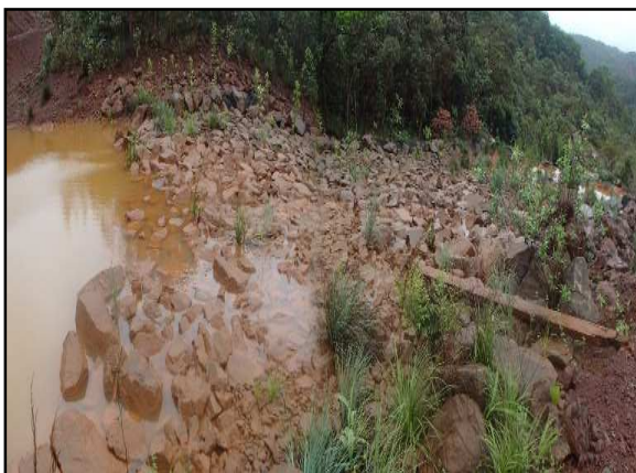
Figure 50 : coursier du BSO, 08/02/17
