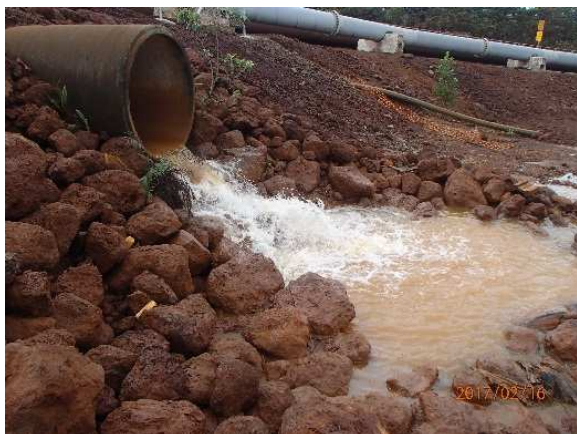
Figure 58 : Déversoir du BS1 – 16/02/17
