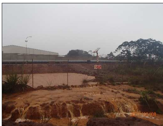
Figure 41 : Débordement du BS2 côté Ouest, 08/02/17
