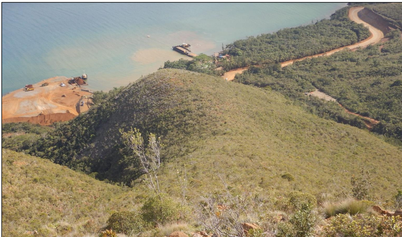
Figure 14 : Label 1 - Vue sur la zone 01 et le wharf de N'Go
