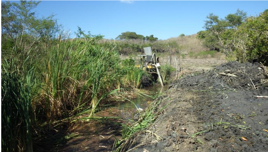
Figure 6 : Exemple Fossé curé avec dépôt des produites de curage lit majeur rivière Pouembout– Tronçon 5
