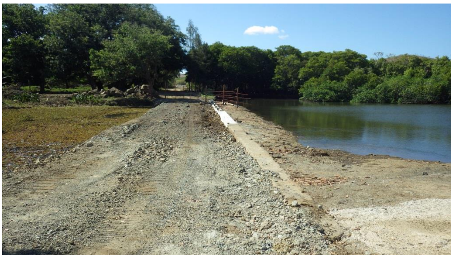
Figure 7 : Barrière Anti-Sel rivière Pouembout – Tronçon 5
