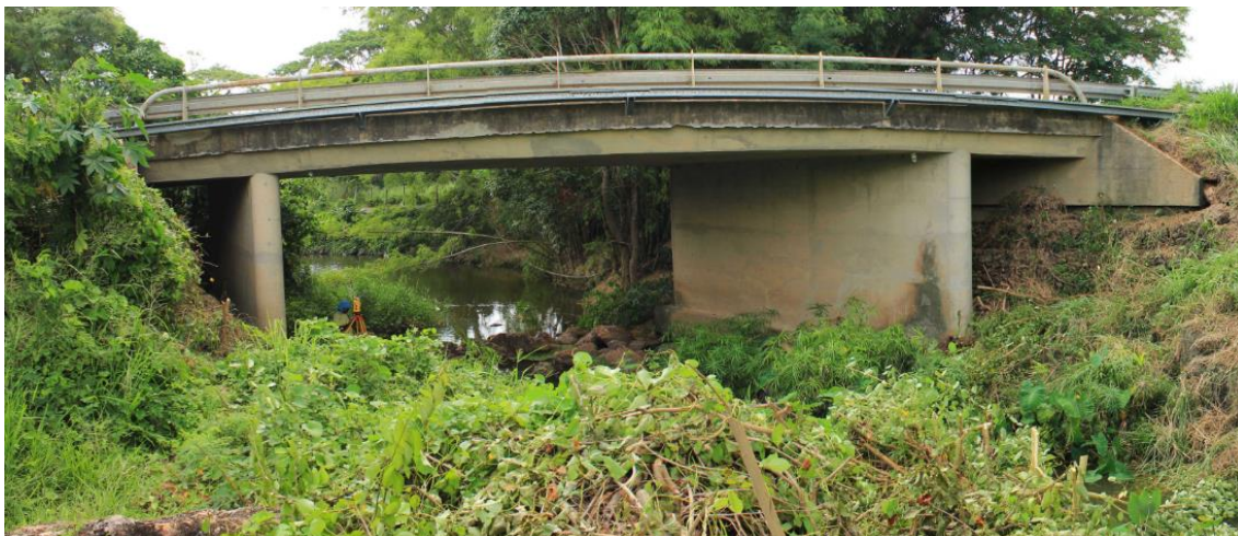
Figure 10 : Photo du pont OH1 de la Nindia
