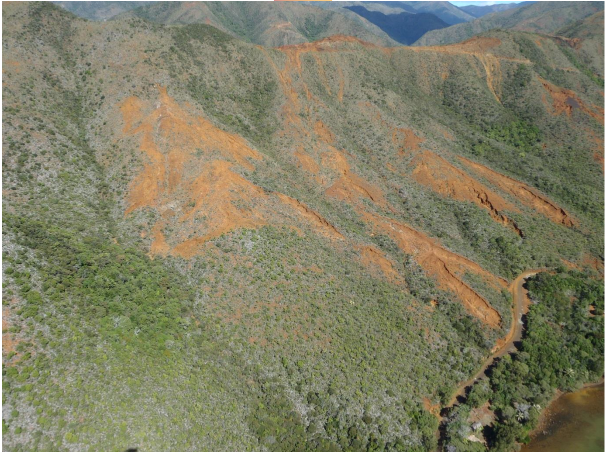
Photo 9 : cliché aérien de la partie Nord de la crête côtière de SMMO21, vue du Nord-est
