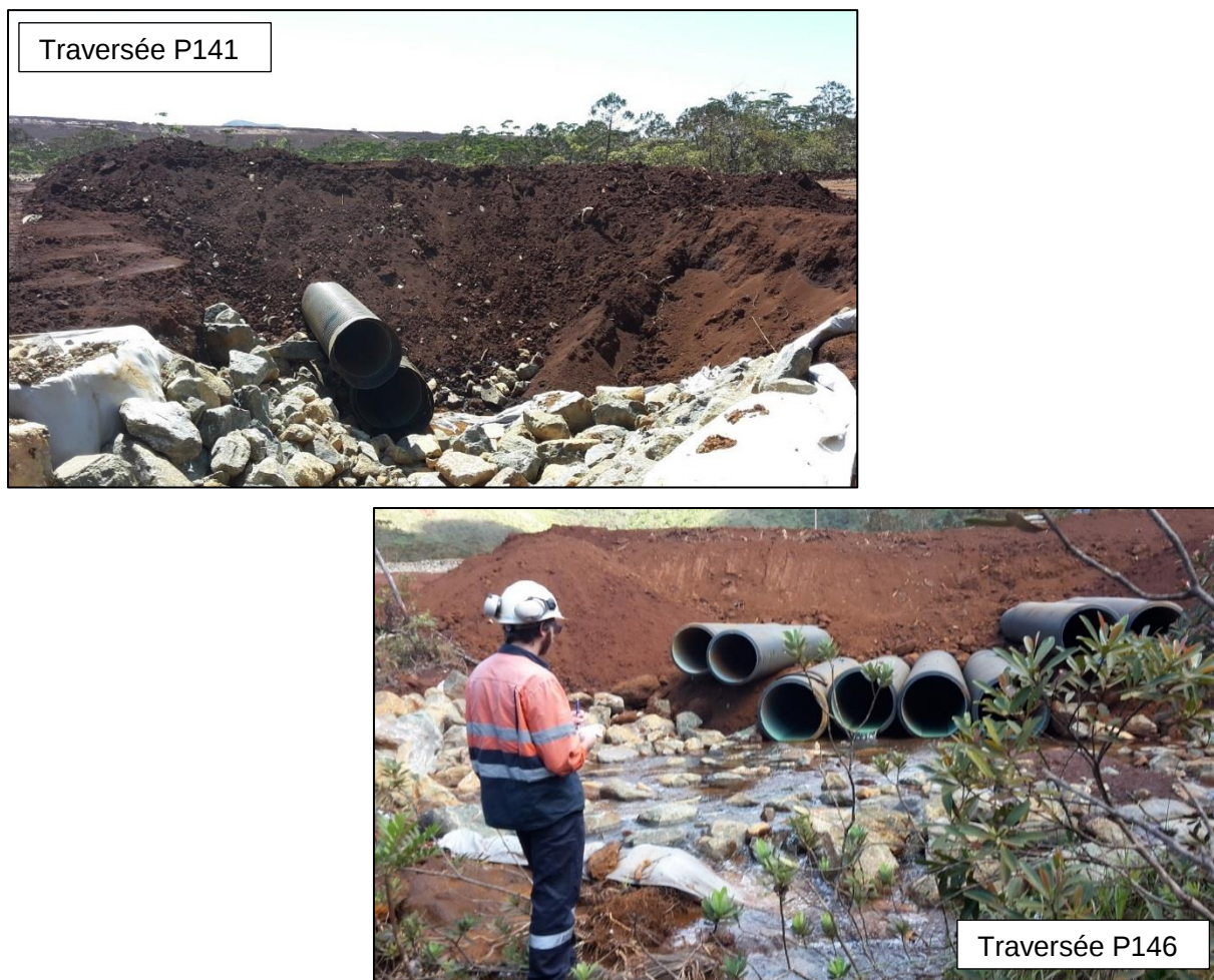
Figure 15. Photographie des ouvrages busés (terrain Néodyme NC : 05/12/2016)
