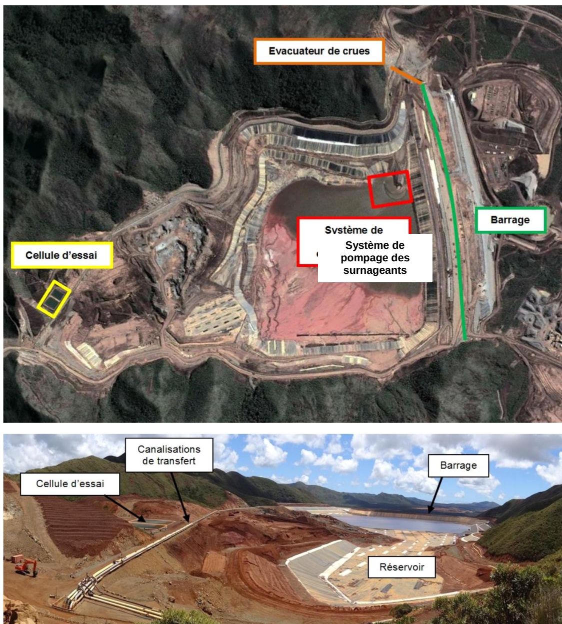
Figure 77. Aménagements du parc à résidus de la Kwé Ouest
