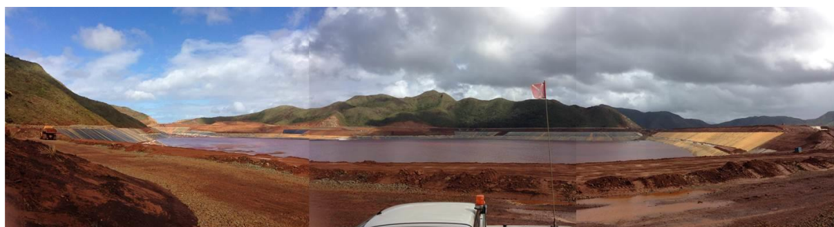
Figure 107. La vallée KO2 – vue sur le flanc collinaire ouest
