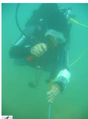
Photo n°01 : Mise en place d'un piquet
