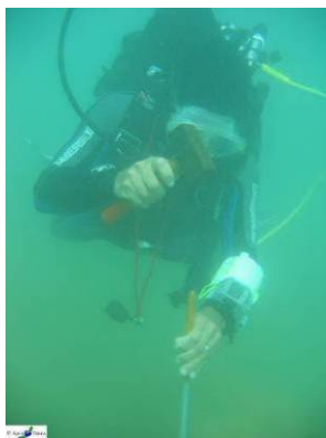
Photo n°01 : Mise en place d'un piquet
