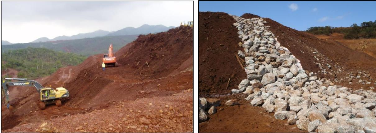
**Figure 3 : Travaux de mise en place de la "terre végétale" (gauche) et de descentes d'eau enrochées (droite) sur VSEM, septembre-novembre 2011**
