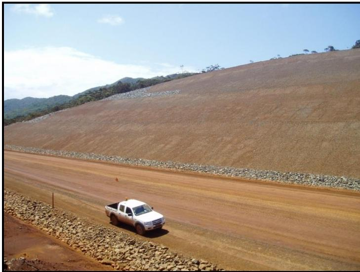
**Figure 2 : Ouvrage de protection par Géoweb finalisé (novembre 2010)**
