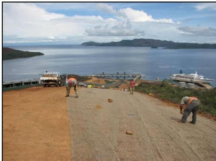
**Figure 11 : Pose de géo-filet sur une pente moyenne le long du convoyeur**
