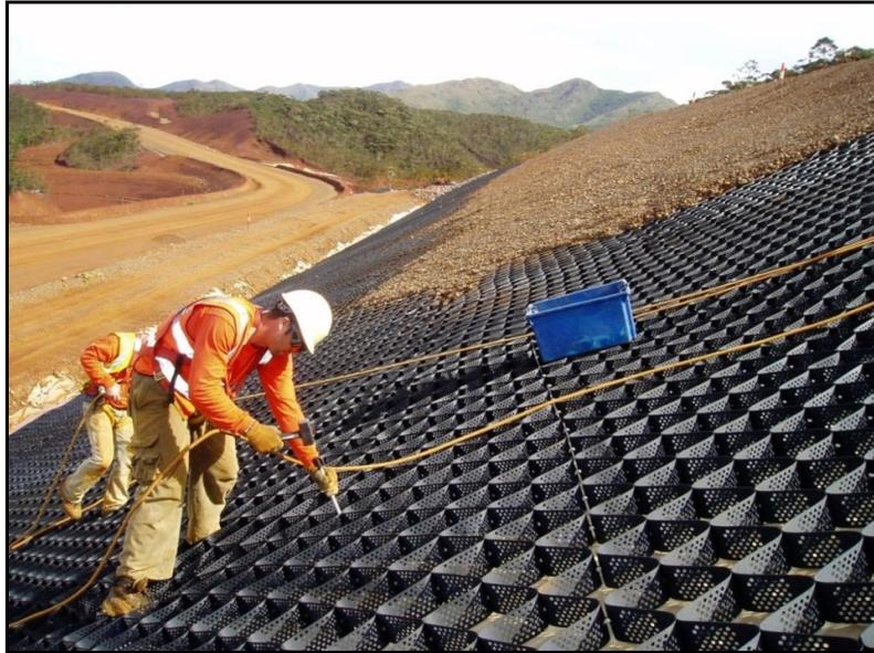
**Figure 1 : Pose de Géoweb sur les talus de la MHR (juin 2010)**
