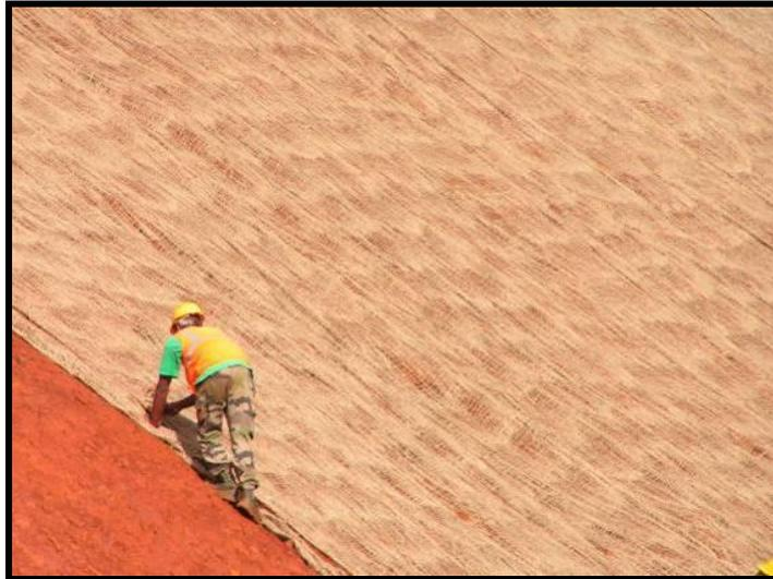
**Figure 10 : Pose de géofilet en toile de jute recouvrant les graines sur un talus de la VSEM**
