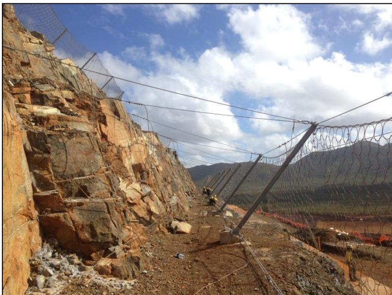
**Figure 6 : Ecrans déformables de type Rav3 sur la zone de la Kué Ouest**
