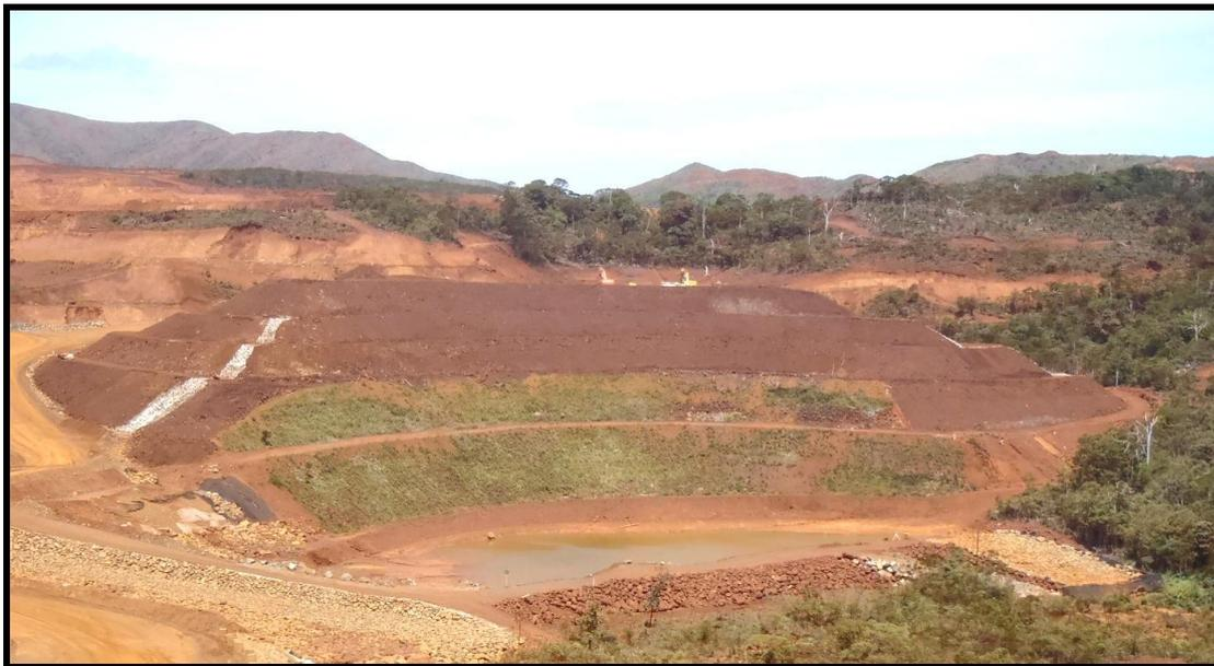
**Figure 4 : Verse VSEM (octobre 2011) - talus inférieurs revégétalisés par hydro-seeding en 2007; talus supérieurs recouverts de terre végétale et re-profilés pour optimiser la gestion des eaux en 2011**
