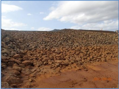
Déversoir du BS6
