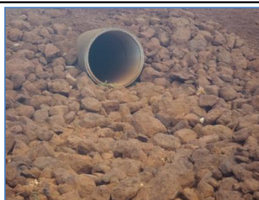
Déversoir du BS1
