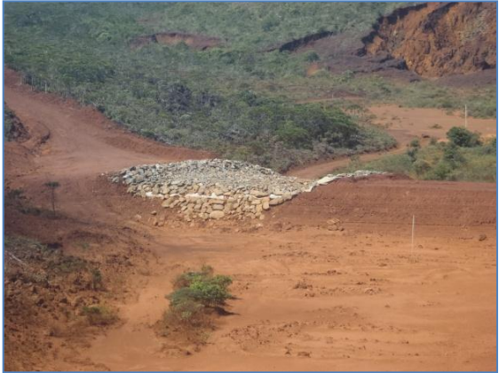
Déversoir du BS8
