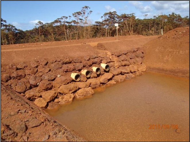
Déversoir du CR10 BS4
