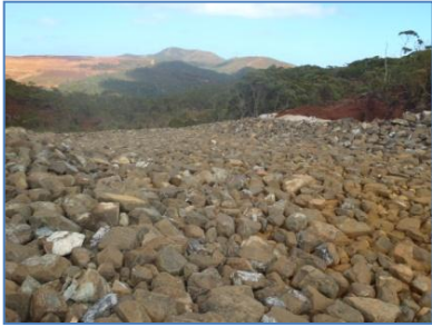
Déversoir du BS3
