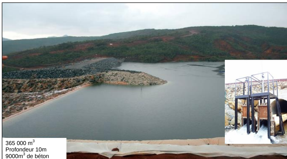
Figure 6 : Le bassin BSKN et sa turbine de production d'électricité
