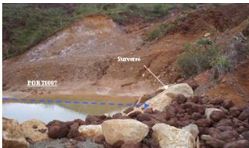
Décanteur (bassin versant du port)
