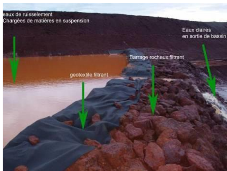
Bassin de sédimentation
