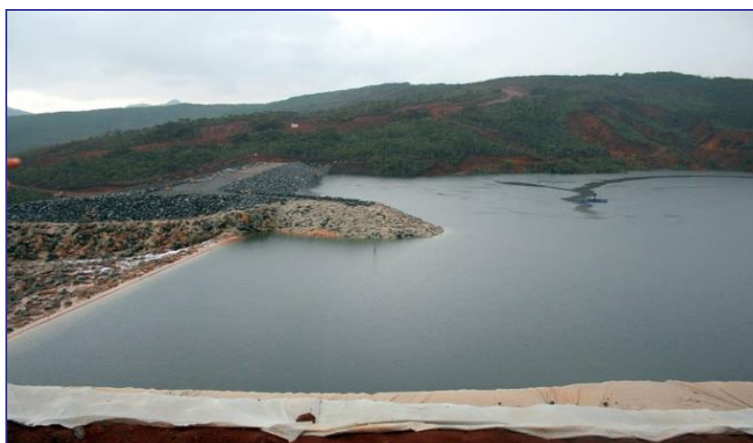
Figure 16: Photo du BSKN en cours de remplissage
