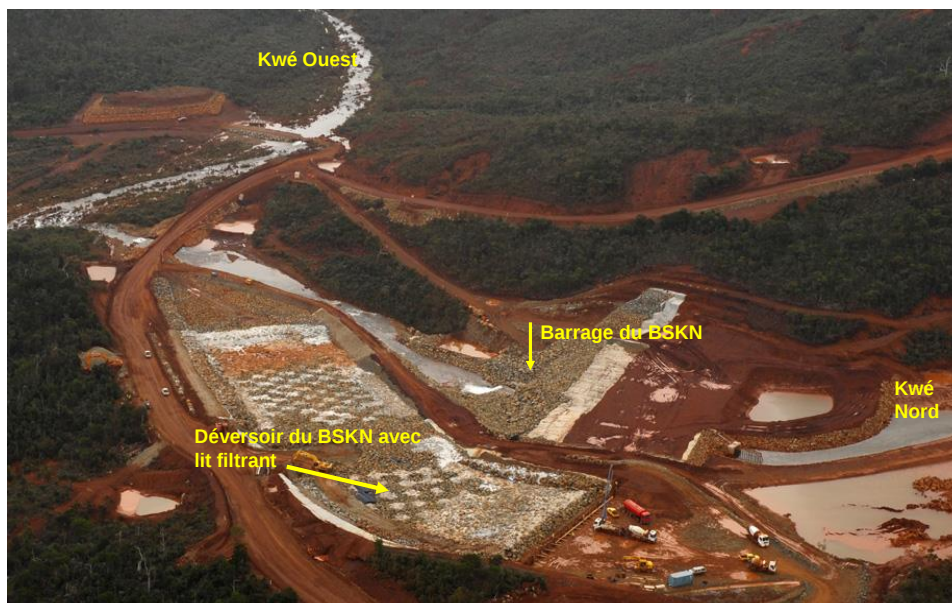
Figure 15 : Photo du BSKN en cours de construction
