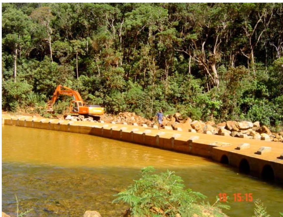
Radier de la Kuébini sur la RM5 : Travaux de la mairie de Yaté
