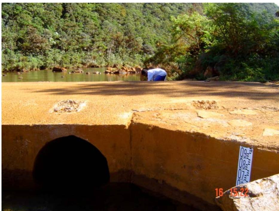
Position de l'échelle E1 sur le radier
