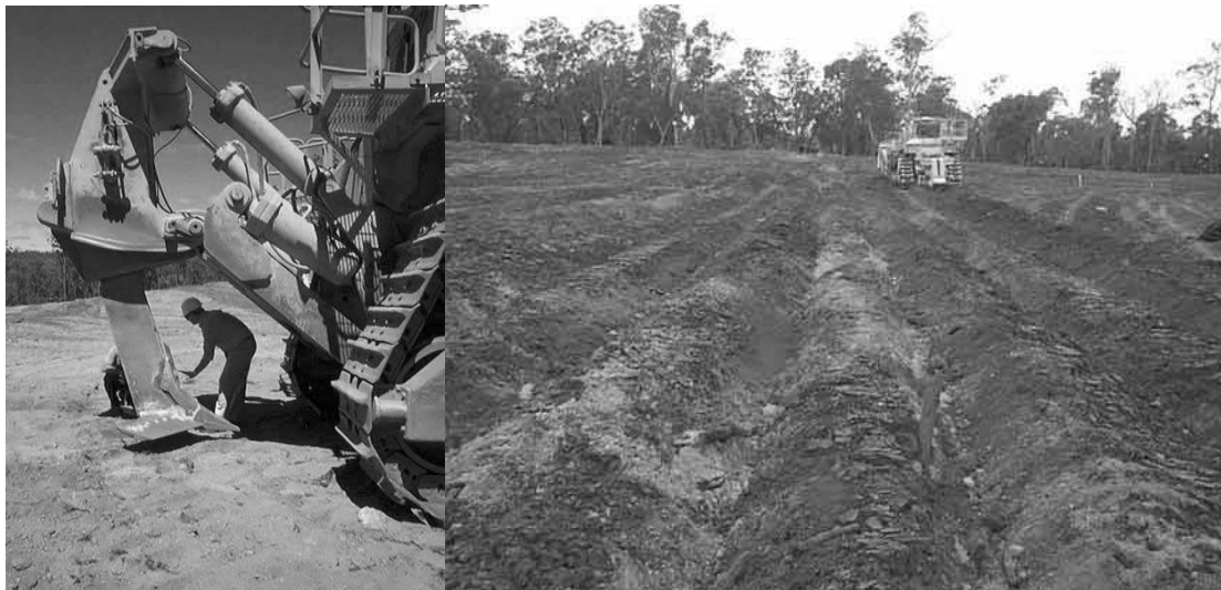
Figure 11 : Aération par ripage du sous sol sur une mine de Bauxite de Alcoa en Australie Occidentale
