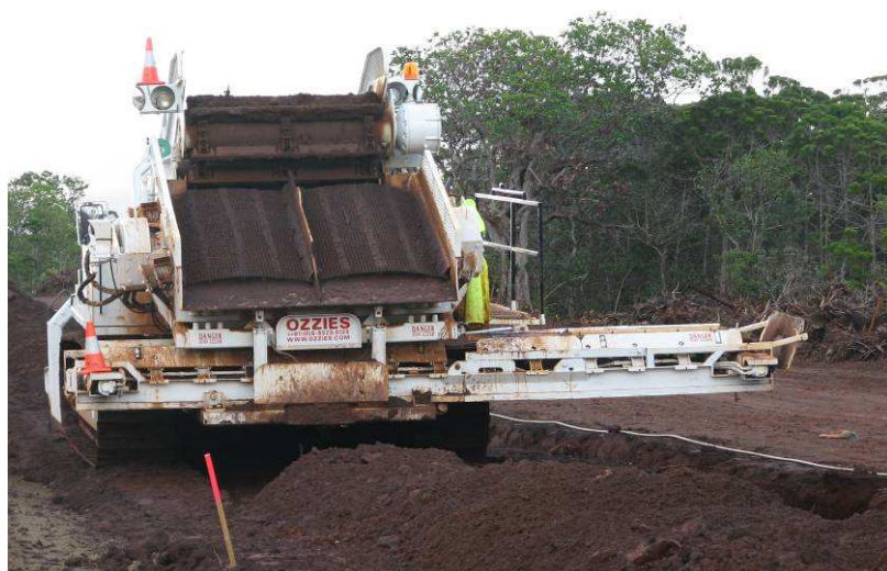
Figure 12 : La remise de la terre végétale sur le tranché du tuyau d'eau de Goro Nickel par un cribleur vibrant sur chenille
