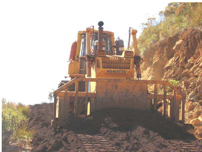
Figure 6: Une opération d'épandage de la terre végétale fait avec le "bush rake"
