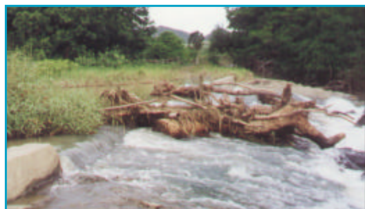
Barrage anti-sel de la rivière Pouembout
