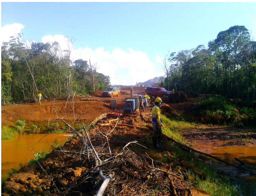
Photo 3 : Système de pompage des 2 bassins de sédimentation du CBN
