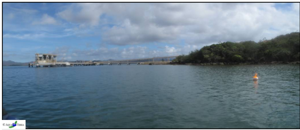
Photo n°09 : Position en surface par rapport aux structures portuaires (ST03)
