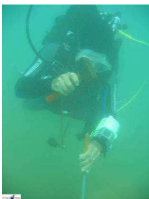
Photo n°01 : Mise en place d'un piquet
